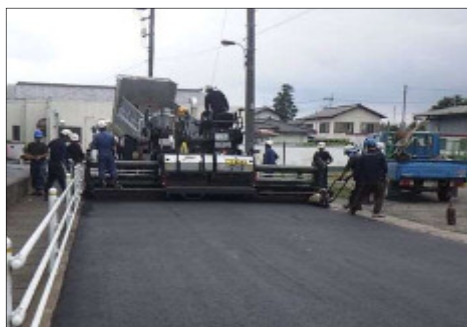
道路等の緊急修繕
