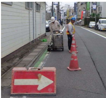
路面表示修繕
