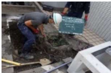
土木緊急修繕の様子
