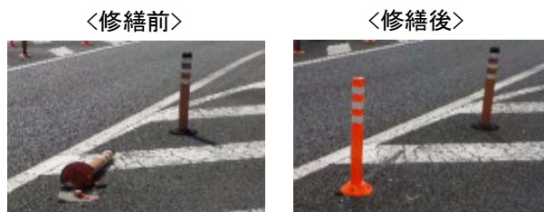
道路緊急修繕
