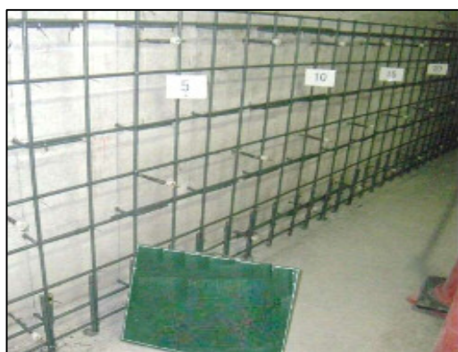
ポンプ場の耐震化（壁の補強状況）
