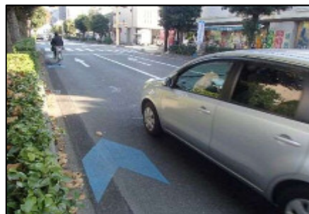
矢羽根の整備事例(市役所通り)
