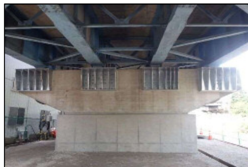
落橋防止装置の取付、橋脚の補強
