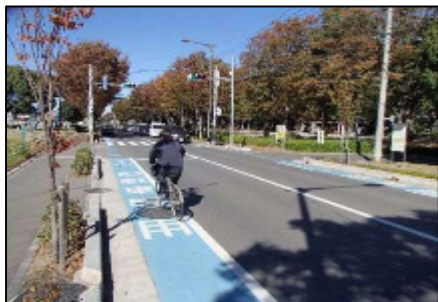
自転車専用通行帯の整備事例(与野中央通り)
