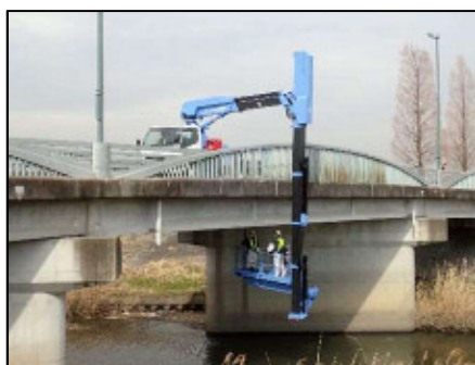
橋りょう点検車による点検
