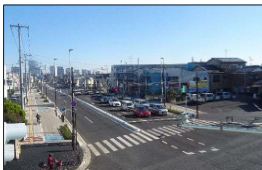
三橋中央通線（三橋工区） 拡幅整備
