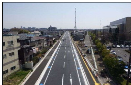
大谷場高木線（道場工区） 新設整備
