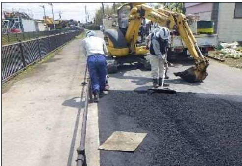
道路の緊急修繕
