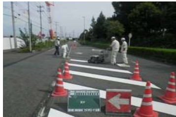
路面表示修繕
