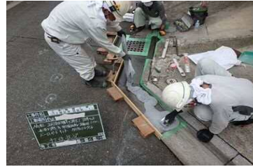
土木緊急修繕
