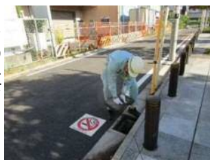
【道路緊急修繕】
