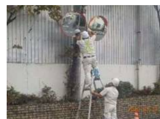
【交通安全施設修繕】
