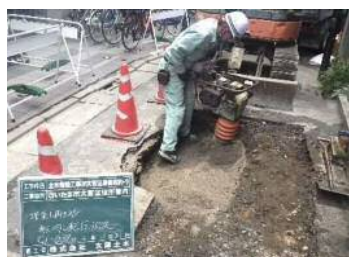
土木緊急修繕の様子
