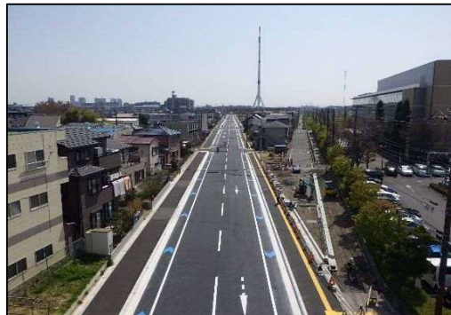
大谷場高木線（道場工区） 新設整備
