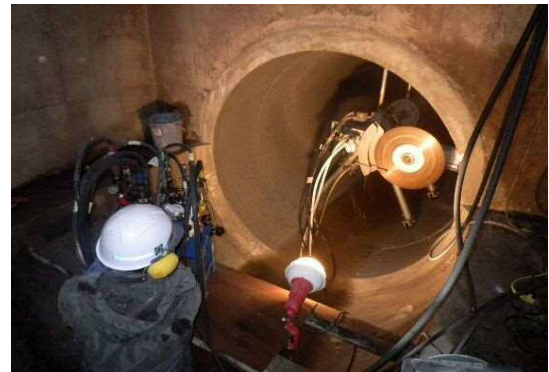
下水道管とマンホールの継手部耐震化
