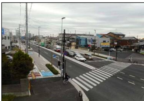
三橋中央通線（三橋工区） 拡幅整備
