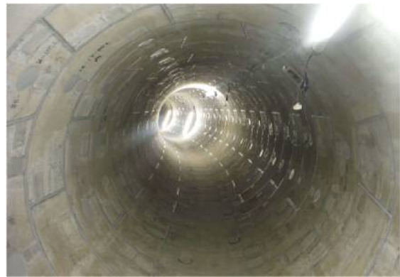
道路の地下を活用した雨水貯留管の整備
