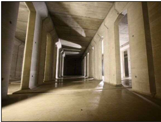
公園の地下を活用した雨水調整池の整備
