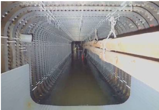
老朽化した下水道管の更生
