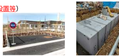
【開発行為で設置された防火水槽】
