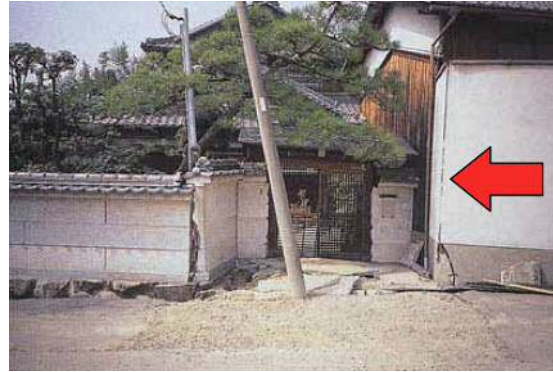
盛土造成地の変動に伴う被害 (大規模盛土造成地の変動予測調査ガイドラインの解説より)
