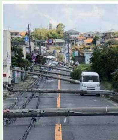
台風により倒壊した電柱
