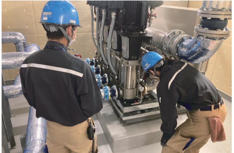
▲設備点検作業
