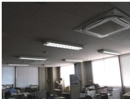
▲事務所LED照明新設エアコン
