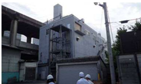
⑪汚水処理施設
