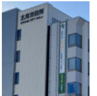
市役所の外壁に設置された懸垂幕 （写真：PwCコンサルティング合同会社）
