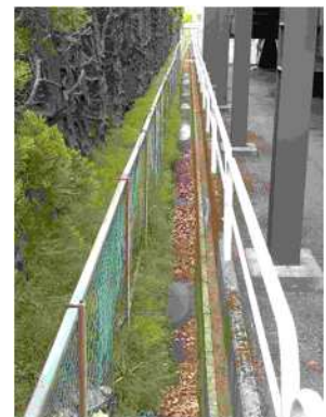
③側溝、フェンス
