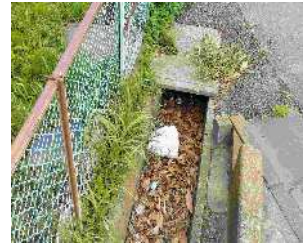
⑥側溝、フェンス
