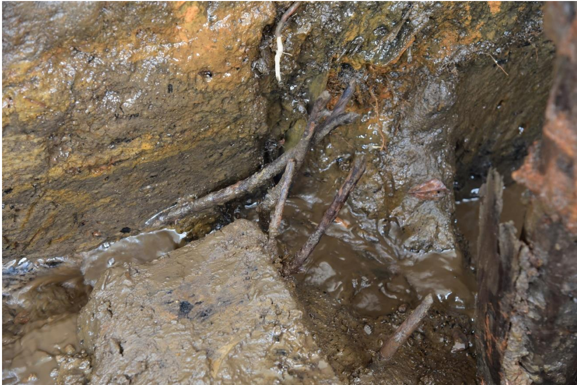
写真7 杭列の背面に打ち込まれた枝状の材
