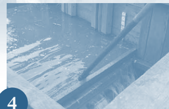
4 一角落を取り付ける。関枠の鳥居柱（関枠中央の太い柱）と水圧によって、角落が固定される。
