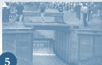
5 一の関に角落を7枚取り付け付けたところ。3の写真と比較すると、水位が上昇していることがわかる（実演開始後、約50分経過）
