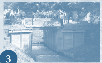
3 一の関に角落を3枚取り付け付けたところ（手前が芝川側）。関枠より上流部分の水位が徐々に上昇していく。
