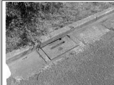
コンクリート部分の側溝の排水の様子
