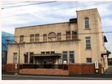
〈 国登録有形文化財（建造物）〉 旧岩槻警察署（岩槻区） 【現岩槻郷土資料館】
