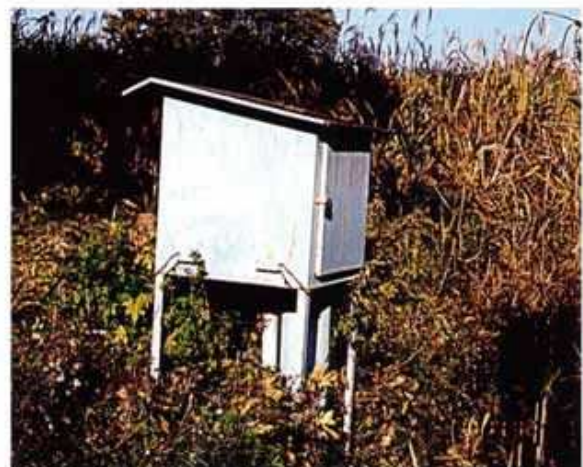
田島ヶ原サクラソウ自生地に設置された観測井戸
