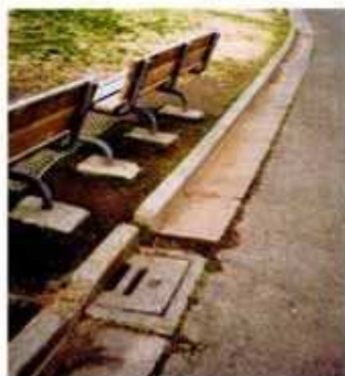
写真4 雨水を流し去る舗装道路と排水施設
