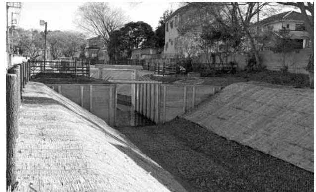
▲再整備工事後の東縁閘門
