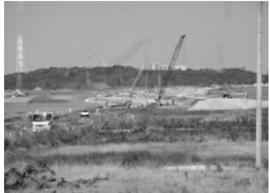
▲南相馬市原町区の雫地区で行われる復旧・復興の工事作業(左側にある煙突は東北電力原町火力発電所)
