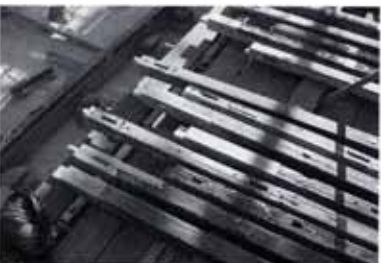
④部材の補修
