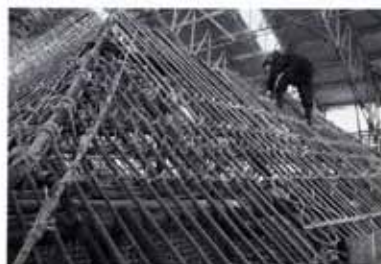
⑦屋根下地
