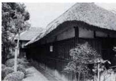
①解体前の遷喬館
