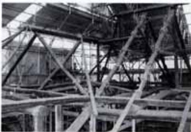
②解体中の様子
