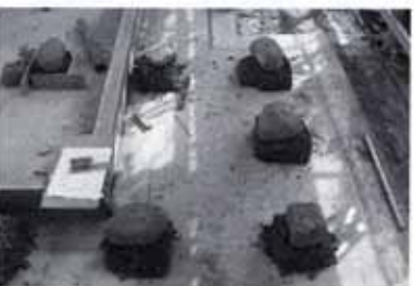
⑤礎石据付
