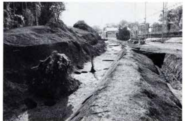
▲中・近世の土壘と堀（土呂陣屋跡）
