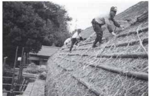
「深井家長屋門」：屋根修理作業
