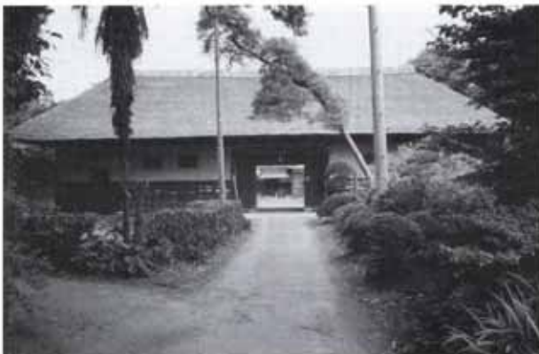
「深井家長屋門」：全景
