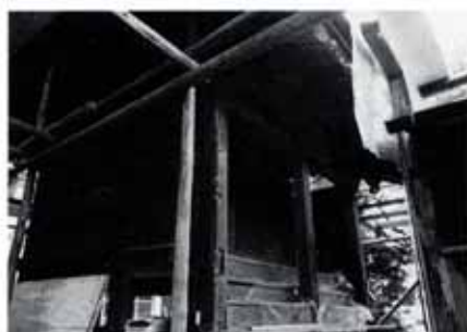
▲解体中の上大久保氷川神社本殿
