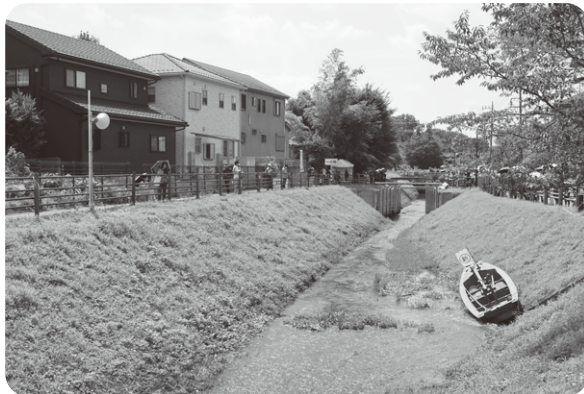
①見沼通船堀東縁。見沼代用水から取り入れられた水は芝川(写真奥)に向かって流れていきます。
