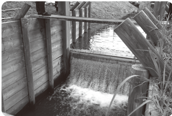
③角落を6枚ほど取り付けたところ。手前に比べて奥の水位が大きく上昇していることが分かります。
