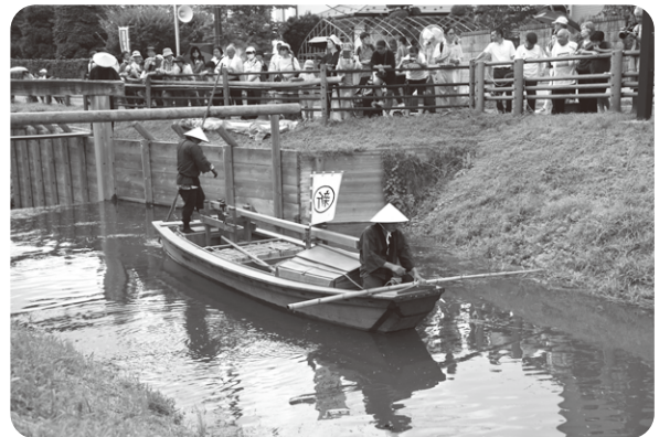
④一の関と二の関の間の水位が十分に上昇すると、船が二の関を通過することができます。(実演では船は関を通過しません。)
