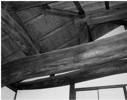
主屋の天井(写真中央、左右に伸びる太い木材が建築当時から残されている梁)
