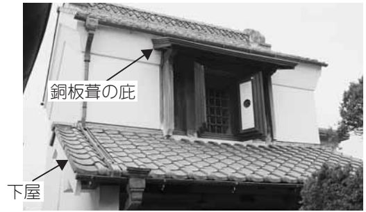
▲2階の庇は銅板葺で、窓回りは黒漆喰で飾られている
