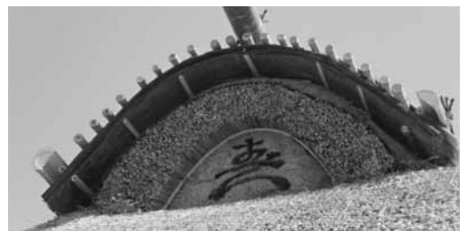
▲消えかかっていた妻飾りも、葺き替えにより復活しました。 上：左側面(「水」の文字) 下：右側面(「寿」の文字)
