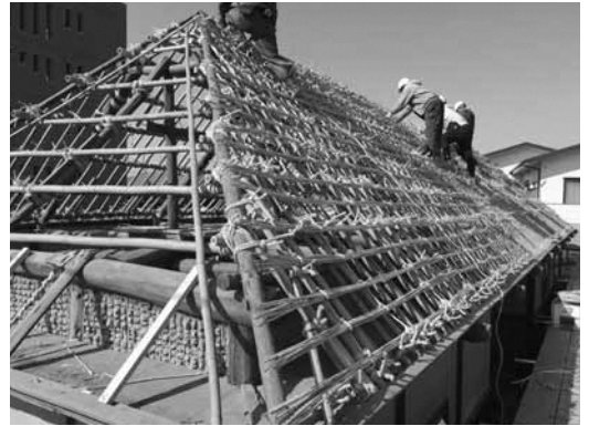
▲葺き替え工事中
