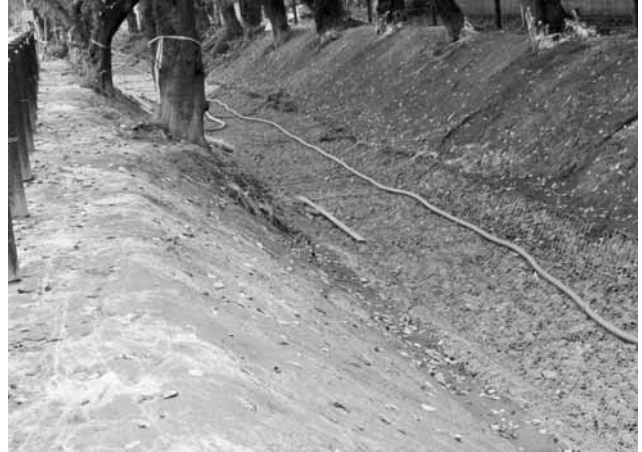
▲連続繊維補強土工施工
