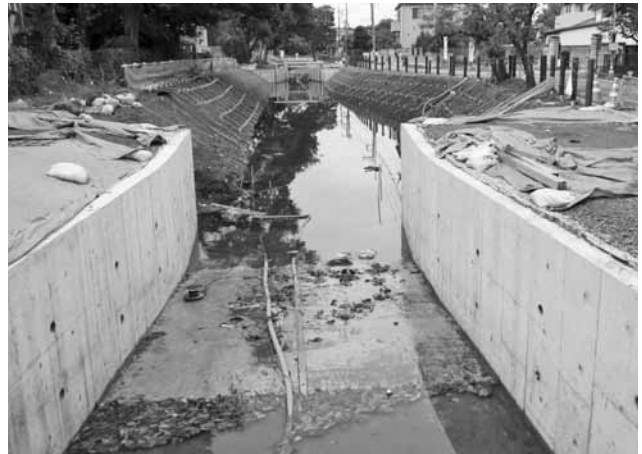
▲地山補強土壁工施工
