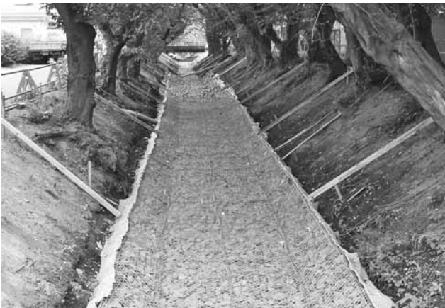
▲河床部根固め工施工
