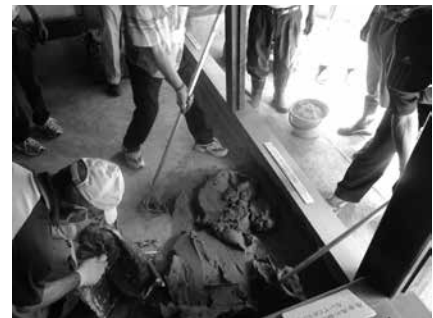
旧綿貫家住宅三和土補修
