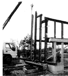
▲材を組み上げる
