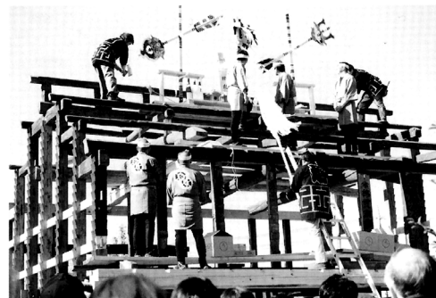
▲槌打ち（棟梁のかけ声により棟木が打たれる）
