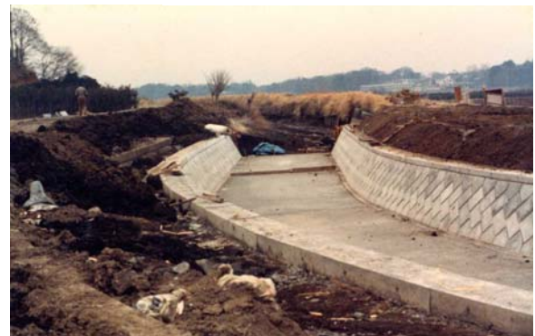
見沼代用水のコンクリート舗装工事
