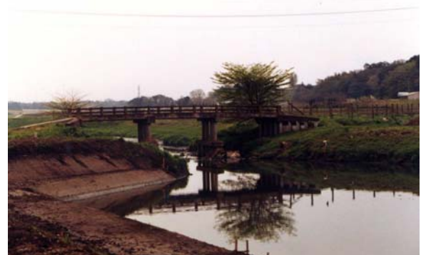
拡幅工事の進む芝川
