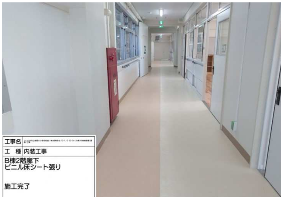
リフレッシュ改修工事後
