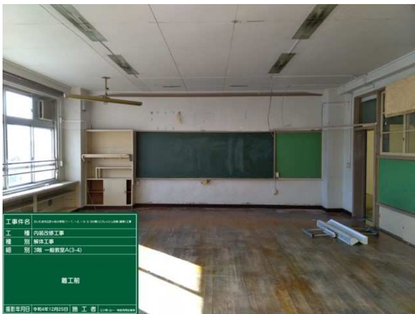
リフレッシュ改修工事前
