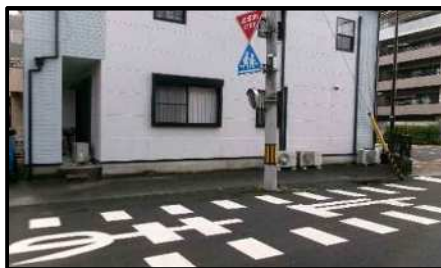
②巻き込み外側線の設置
