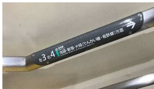
武蔵浦和駅構内 階段の手すりの点字表示 写真提供：JR 東日本大宮支社
