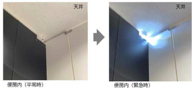
図 07-8 便所内のフラッシュライト(光の点滅で非常時の警報を知らせる装置)
