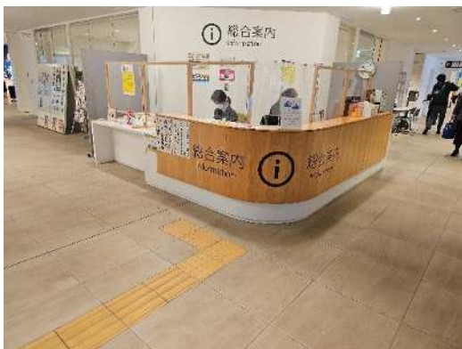
図 17-4 カウンター付近の視覚障害者誘導用ブロックの敷設例
