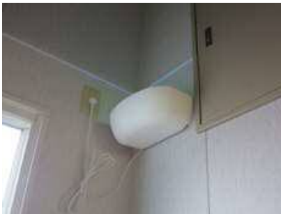
捕虫器は外に光が漏れないよ うに設置する
