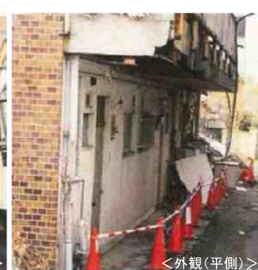
外壁、手すりが崩落した事例
