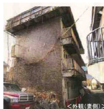
外壁、手すりが崩落した事例
