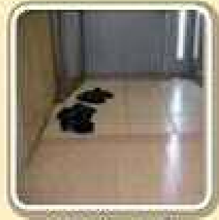
段差のない玄関
