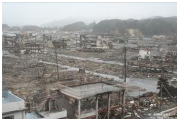
東日本大震災における津波と津波火災による市街地被害(岩手県山田町) 出典：一般財団法人消防科学総合センター災害写真データベース
