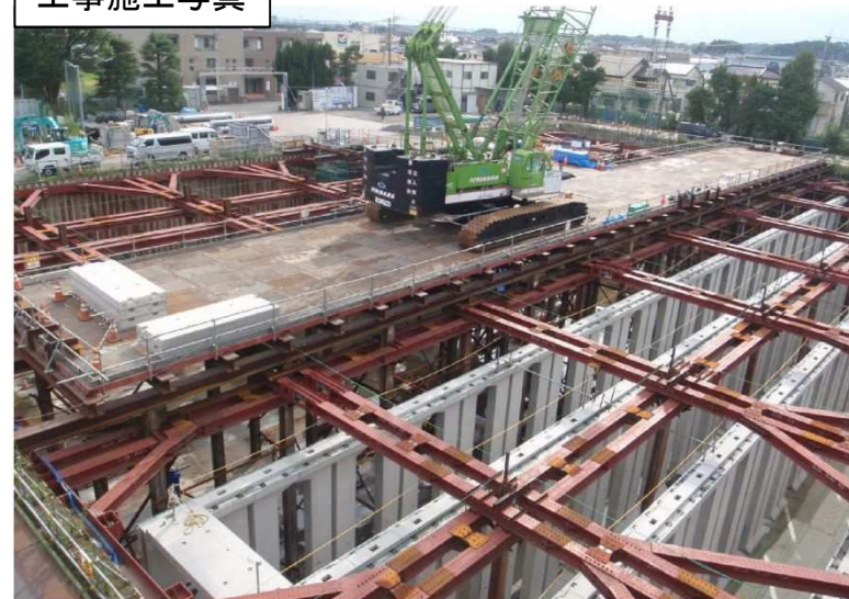
工事施工写真
