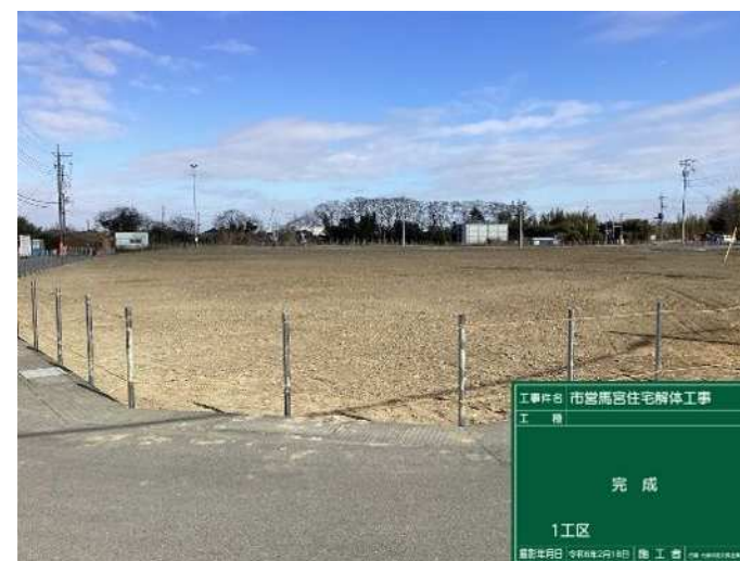
【解体工事前後】
