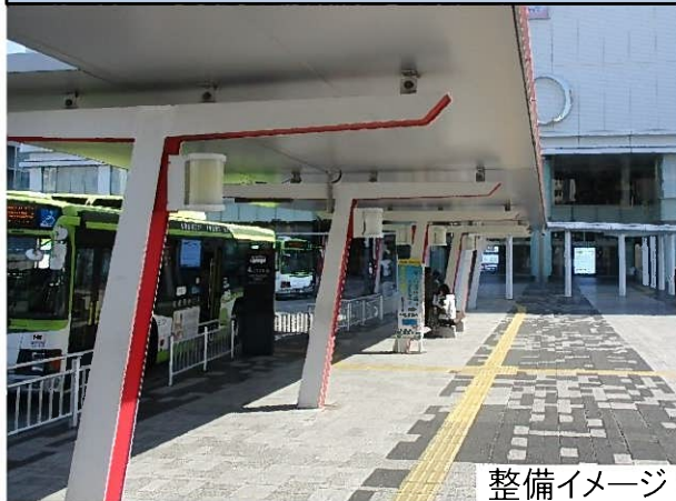
シェルター整備
