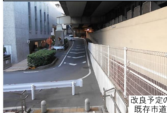
既存市道の改良
