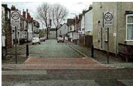
写真 最高速度の区域規制と物理的 デバイスの設置例 / イギリス (出典：コミュニティ形成マニュアル)
