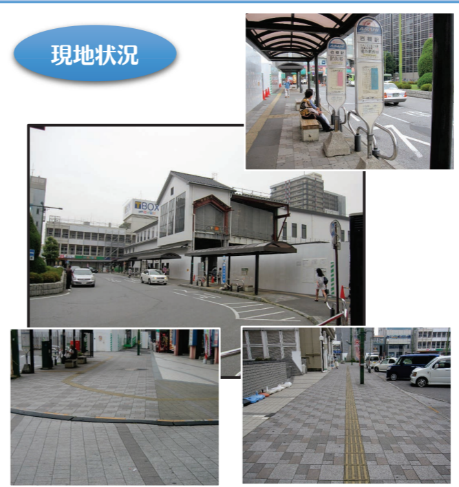
歩車道境界の段差の解消や誘導用ブロックの敷設、バス・タクシー乗り場では上屋が設置されていますが、老朽化等の問題もあり、新たな整備が待たれます。
