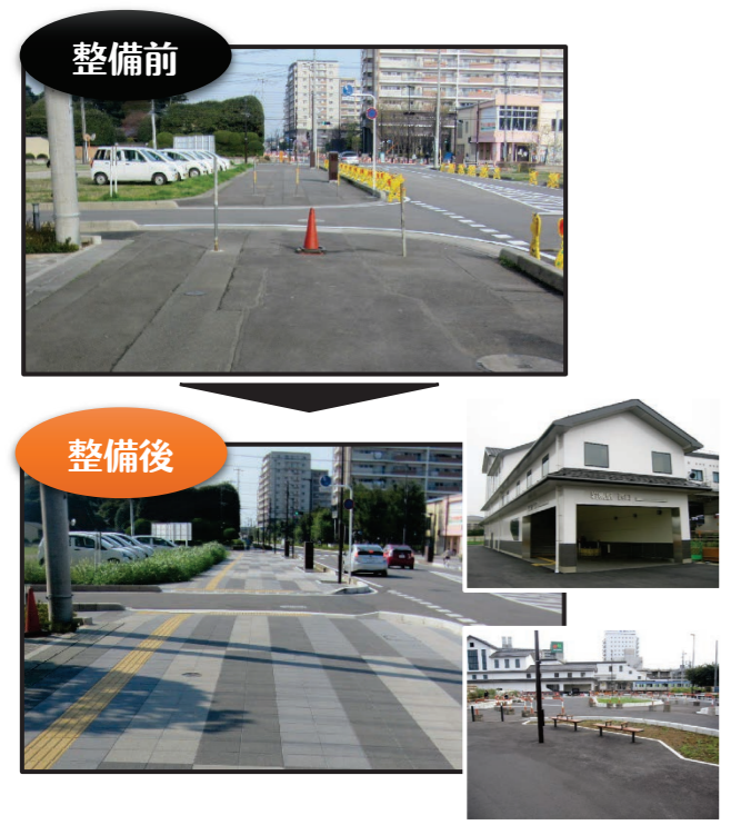
滑りにくく水の浸み込む舗装、色や形状など規格に合った誘導用ブロックが整備され、西口駅前広場にはベンチなどが設置されました。
